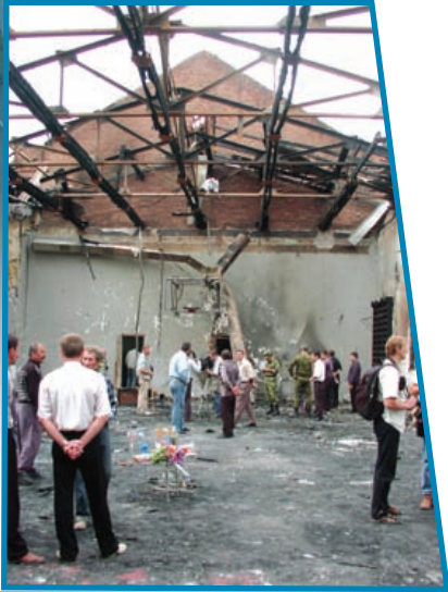
Руины школы №1 в г. Беслане.
